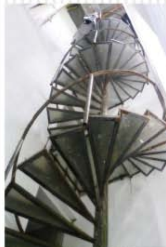
Escaleras tipo caracol
